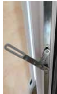
Verrou toute hauteur Pour déverrouillage semi-fixe oscillo-battant
